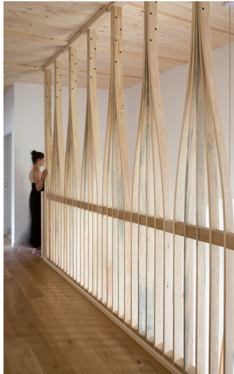
Garde-corps en bois bleu d'une maison à Nancy, réalisé avec de fines planches d'épicéa des Vosges. Architecture : Christophe Aubertin (Studio Lada). Menuisier ébéniste : Alexandre Hubert.
