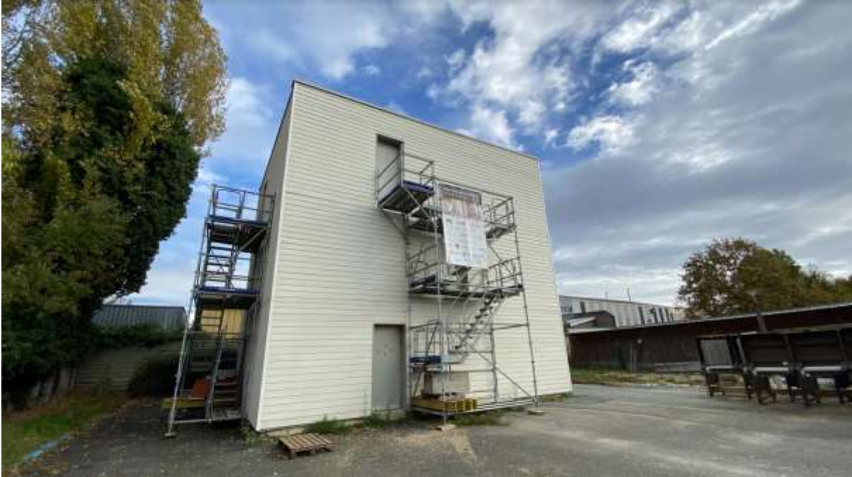
Figure 26 - Vue générale de la structure AdivBois, avec les escaliers externes pour accéder aux différentes salles.
