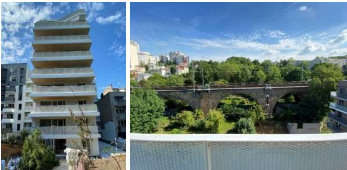
Figure 2 - Bâtiment Hoya à Issy les Moulineaux
