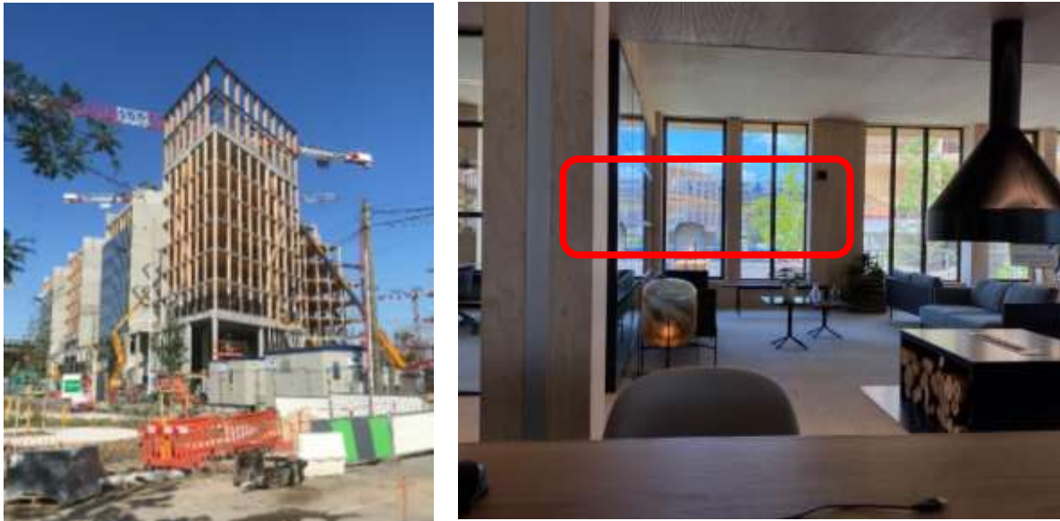
Figure 3 - Chantier Arboretum – Intérieur du bâtiment démonstrateur testé
