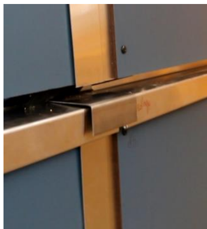
Photo 6 : Eclisse pour assurer la continuité de l'étanchéité de la bavette horizontale
