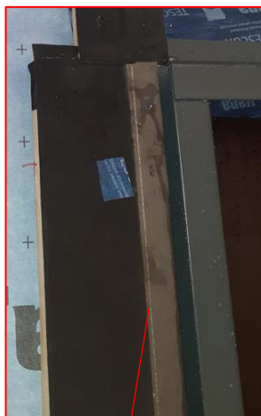
Photo 1 : Fixation du rail métallique
