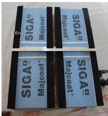
Photo 5 : Pose des tasseaux bois au droit des montants et de la bavette
