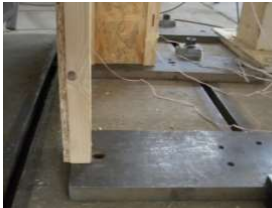
Photo 5 Repos des montants en pied de trumeau
