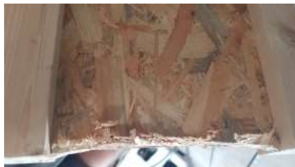
Photo 27 Ecrasement de l'âme OSB en pied de montant
