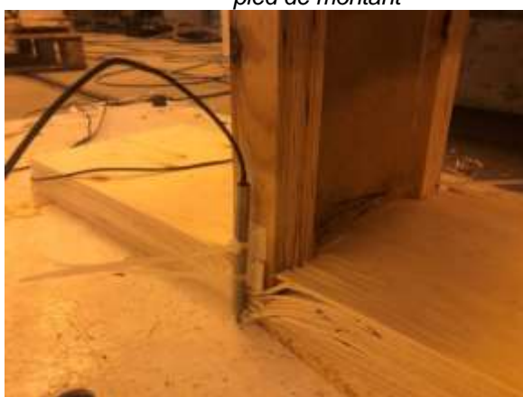
Photo 28 Ecrasement de l'âme en panneau de fibres dur en pied de montant
