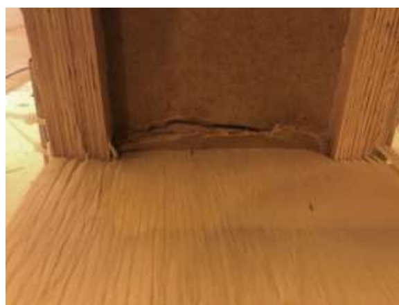
Photo 29 Ecrasement de l'âme en panneau de fibres dur en pied de montant
