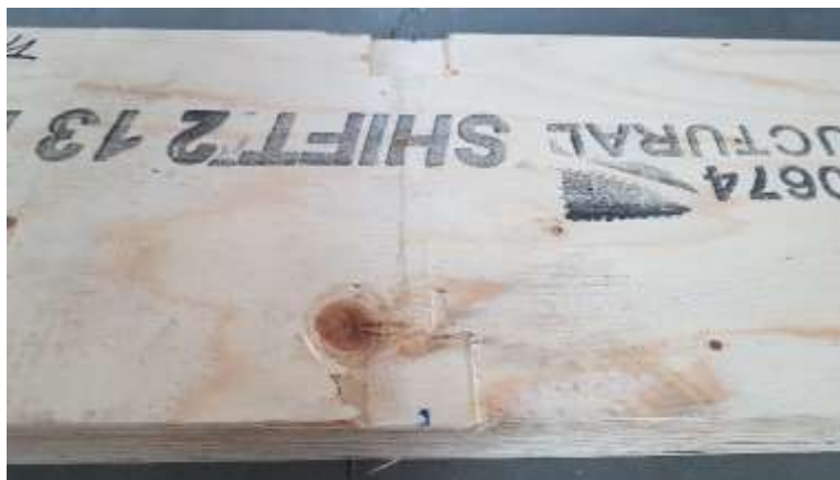
Photo 21 Ecrasement de la traverse sous le montant poutre en I
