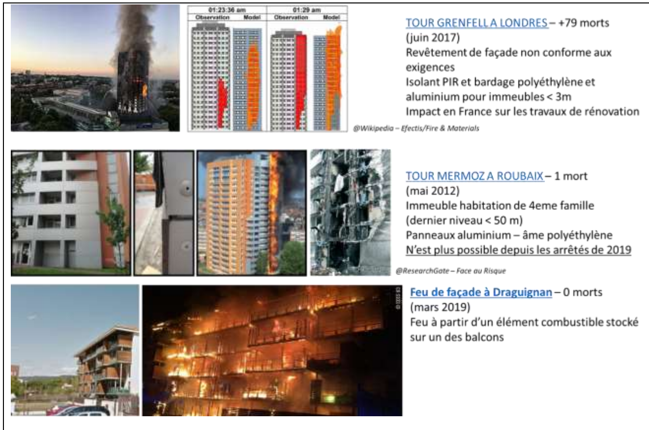
Figure 1 Retours d'expérience en matière de feu façade sur trois bâtiments
