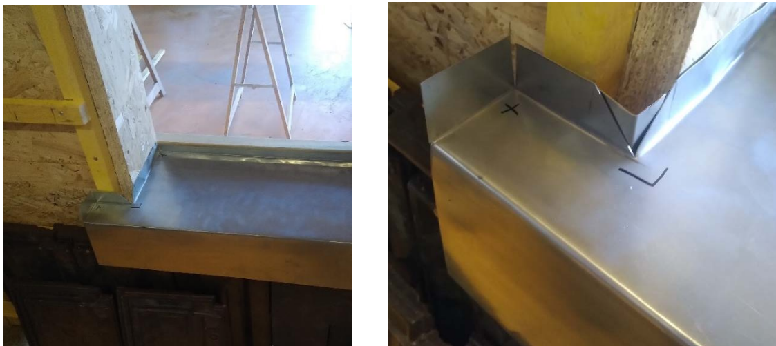
Photographies 2 : détail de bavette basse sur pièce d'appui, avant la mise en place d'un gousset soudé sur l'angle (gauche) et mise en place du gousset à souder et soudures à faire (marques) (droite)
