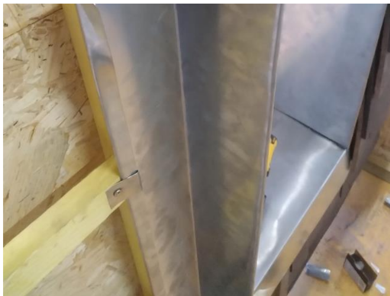
Photographie 5 : Traitement des couloirs latéraux avec pattes de fixation. Les couloirs latéraux sont raccordés avec la bavette basse par recouvrement afin d'évacuer l'eau.
